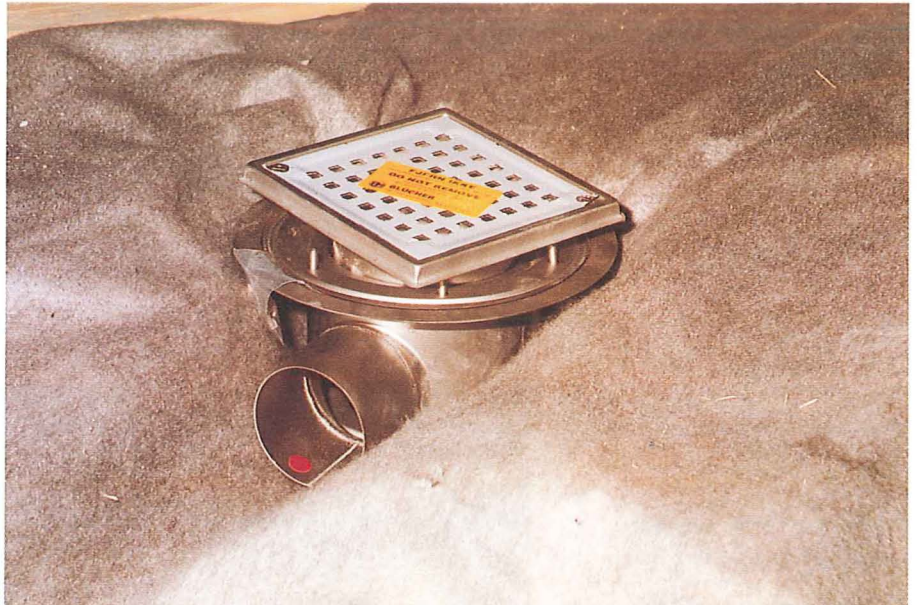
Foto 2. Geotekstil udlagt i udsparring for gulvafløb.
