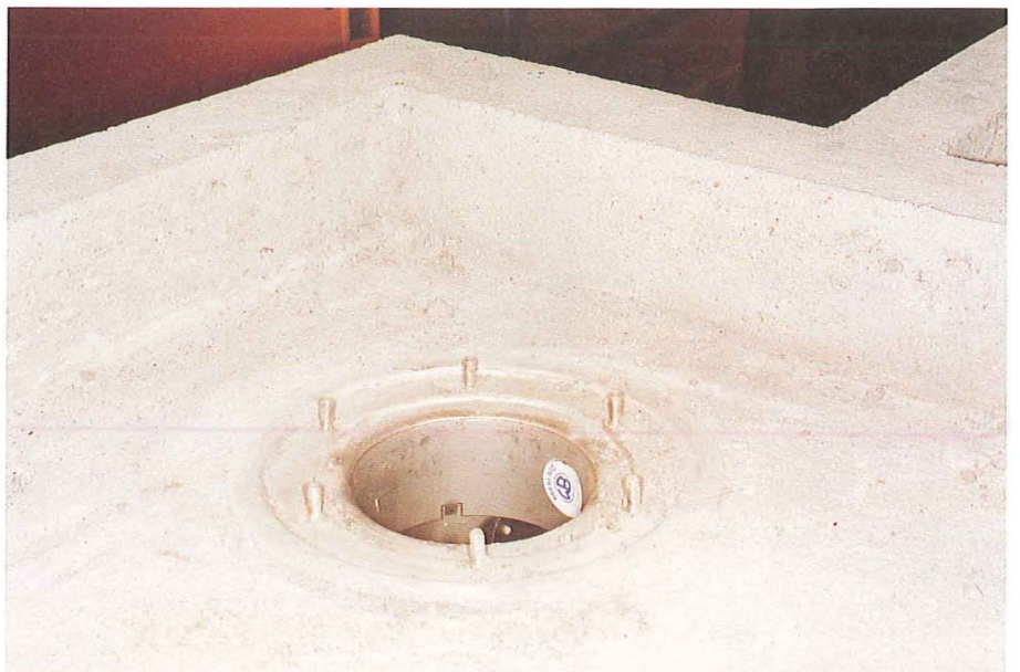
Foto 3. Støbte opkanter for væg- ge. Indstøbt gulvafløb.
