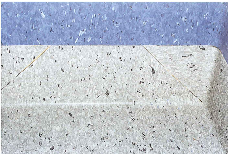
Foto 5. Pvc opsat på gulv og vægge i bruseområdet. Der er endnu ikke foretaget svejsning af skråsnettene og af overgangen imellem gulv og vægge.
