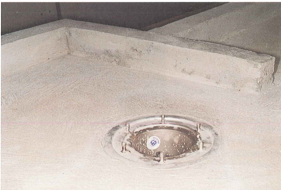
Foto 3. Støbte opkanter for vægge. Indstøbt gulvafløb.
