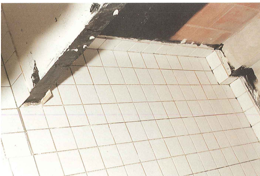
Foto 6. Gulvklinker udlagt og opsætning af vægfliser på brusevinger påbegyndt. Brusevinger påført vandtæt lag.
