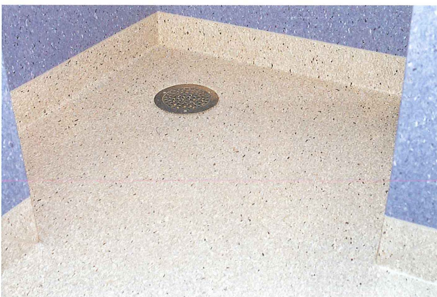
Foto 6. Det færdige bruseområde beklædt med pvc på gulv og vægge.
