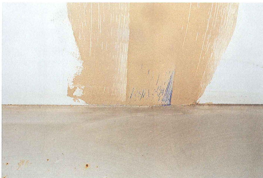
Foto 4. Der er foretaget spartling af samling imellem to calciumsilikatplader indstøbt i glasfiberarmeret polyester i bruseområdet.
